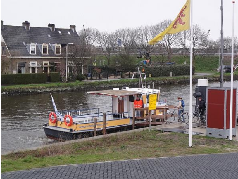
Alphen aan den Rijn. Tijdelijk fiets-/voetveer bij herstelwerkzaamheden aan de hefbrug over de Gouwe.
